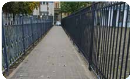
Ул. Льва Толстого, д. 19. Ремонт плиточного покрытия
