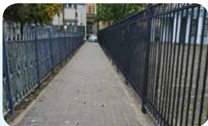
Каменноостровский пр., д. 65 (ремонт асфальтобетонного покрытия)
