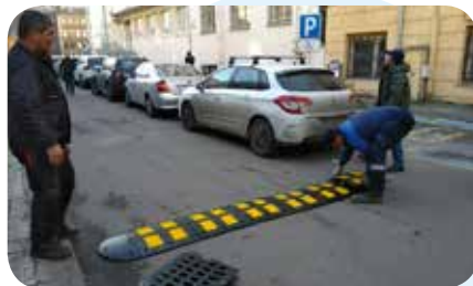
Каменноостровский пр., д. 55. Устройство ИДН у МФЦ
