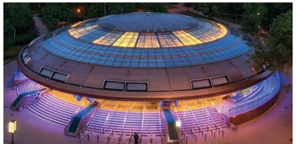
Станция метро «Горьковская»
